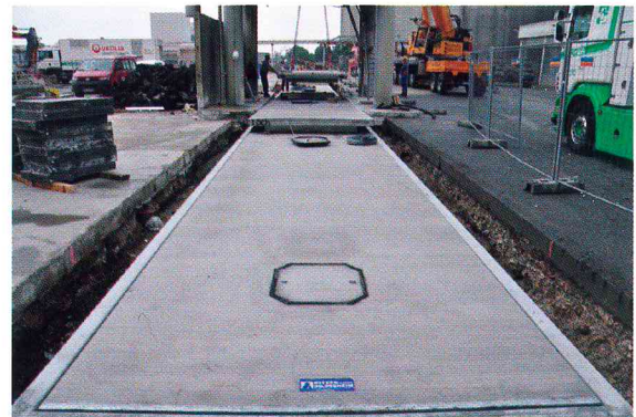
Einbau einer 36x3m Fahrzeugwaage unter einem Silo
