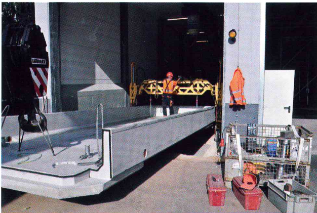
Einrollen der Fundamentwanne in eine vorhandene Halle
