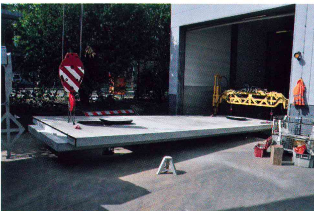
Einrollen der Waagenbrücke
