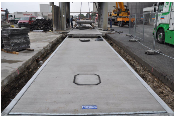
Abb. 2 Einbau einer 36m BITZER Verladewaage
