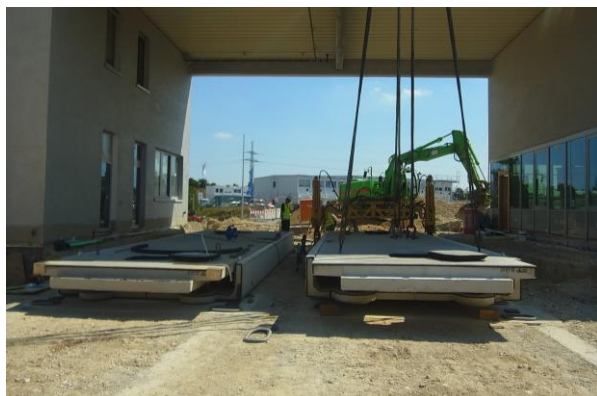
Abb. 2 Einbau von zwei Fahrzeugwaagen mithilfe eines hydraulischen Rollportals
