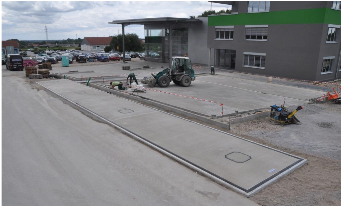
Einbau einer Komplettfahrzeugwaage in Überlänge
