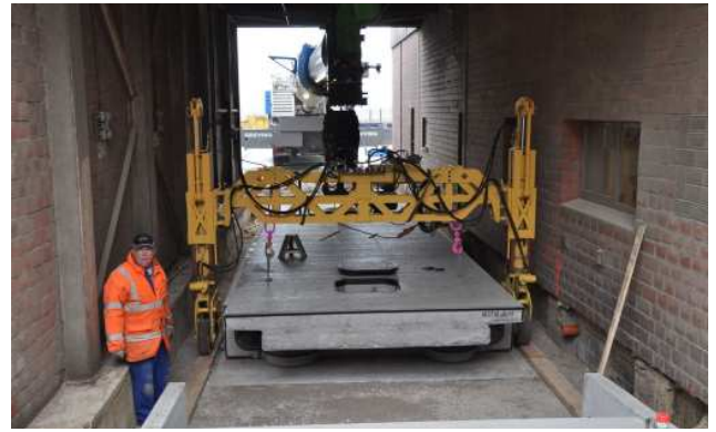
„Einrollen“ einer 26 m langen Komplettfahrzeugwaage
