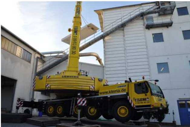
Einheben einer Fahrzeugwaage über Gebäude
