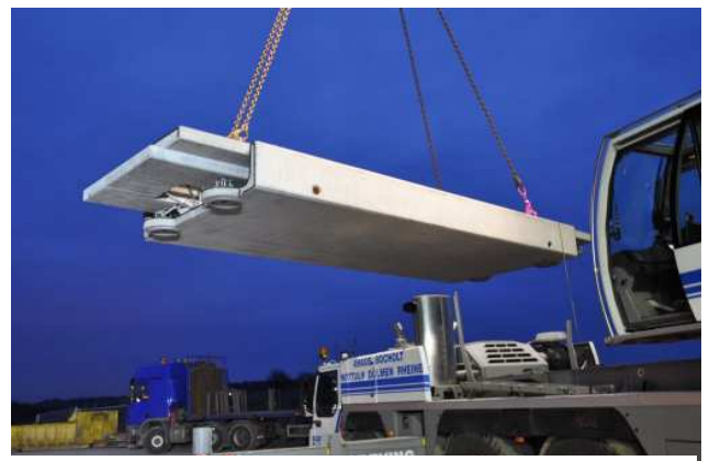
Montage einer Fahrzeugwaage
